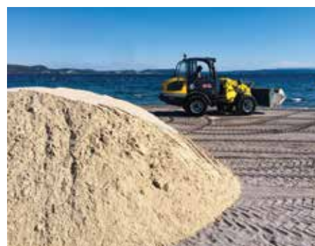
Les services techniques fortement impliqués dans les aménagements.
