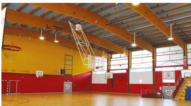
Opération : rénovation des murs et des gradins du gymnase. Coût : 28 500 €
