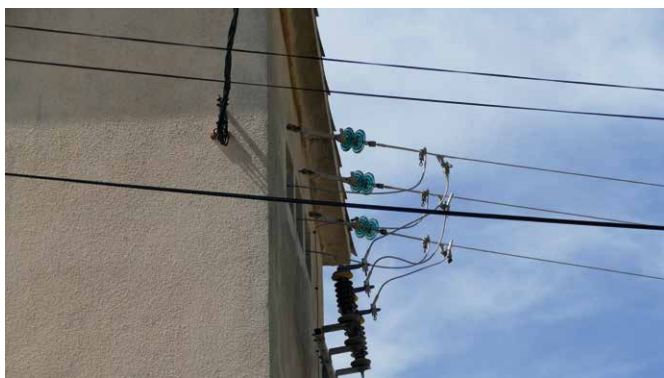
Opération : enfouissement des réseaux électriques. Coût : 230 594 €
