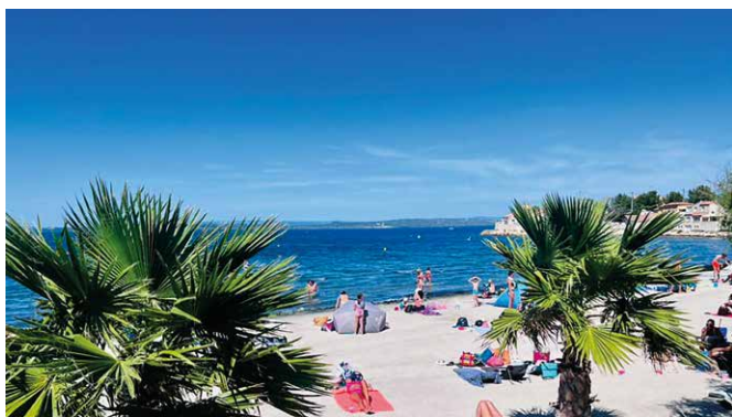
Opération : création de toilettes plage de Massane. Coût : 56 210 €
