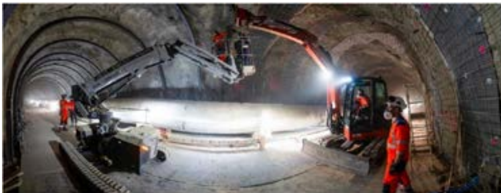
Pose des treillis pour soutènements
